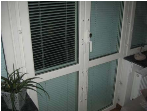
Fastigheten har idag fönster av 3 glas typ.
